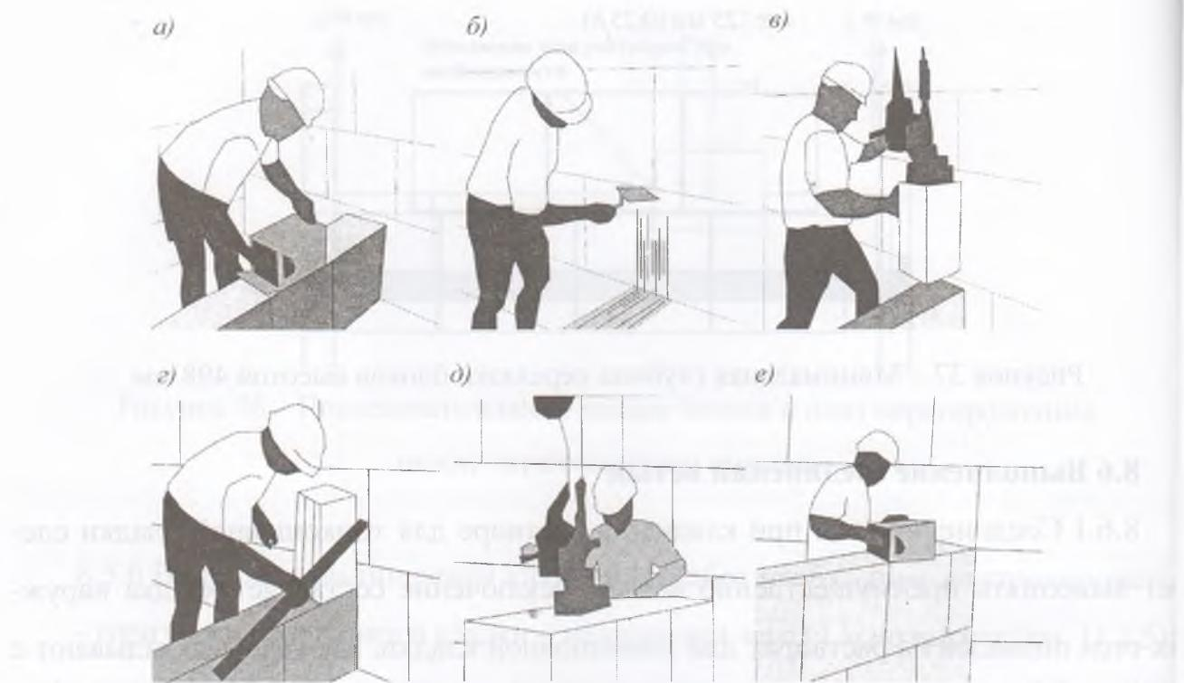
**а)** – выполнение горизонтального шва; **б)** – выполнение вертикального шва; **в)** – установка первого блока в ряду; **г)** – выравнивание установленного блока; **д)** – установка последующих блоков; **е)** – выполнение горизонтального шва следующего ряда
