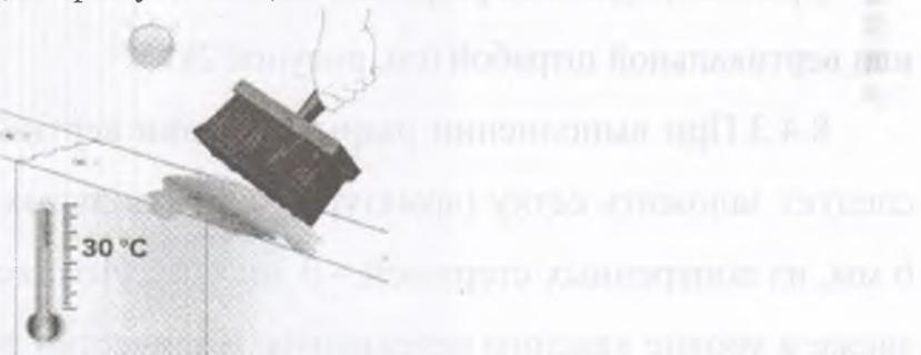
Рисунок 30 – Предварительное увлажнение рядов кладки
